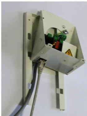
lange Wandhalterung an die Wand schrauben und Datenkabel-Stecker in die Buchse unten am Timi stecken
